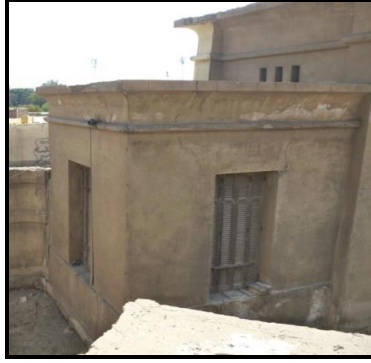
لوحة (١٤) الواجهة الشمالية الغربية والشمالية الشرقية لحجرة التي تقع بالضلع الشمالي الشرقي لدركاة المدخل وتشرفا على الفناء المكشوف. تصوير الباحثة"
