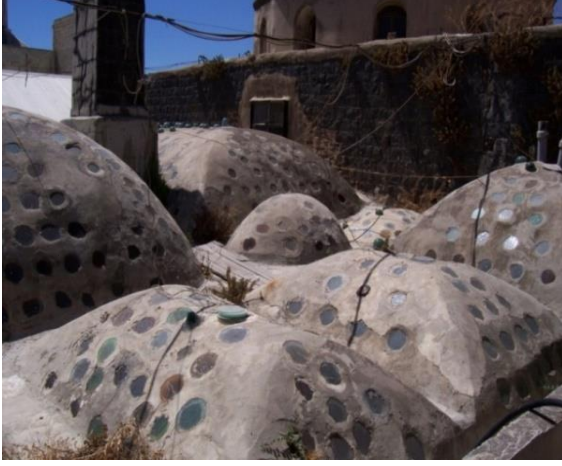
(لوحة ٢١): حمام العثماني بمدينة حمص ١٣١٥هـ/ ١٨٩٧م وإعادة تأهيله (توظيفه).
