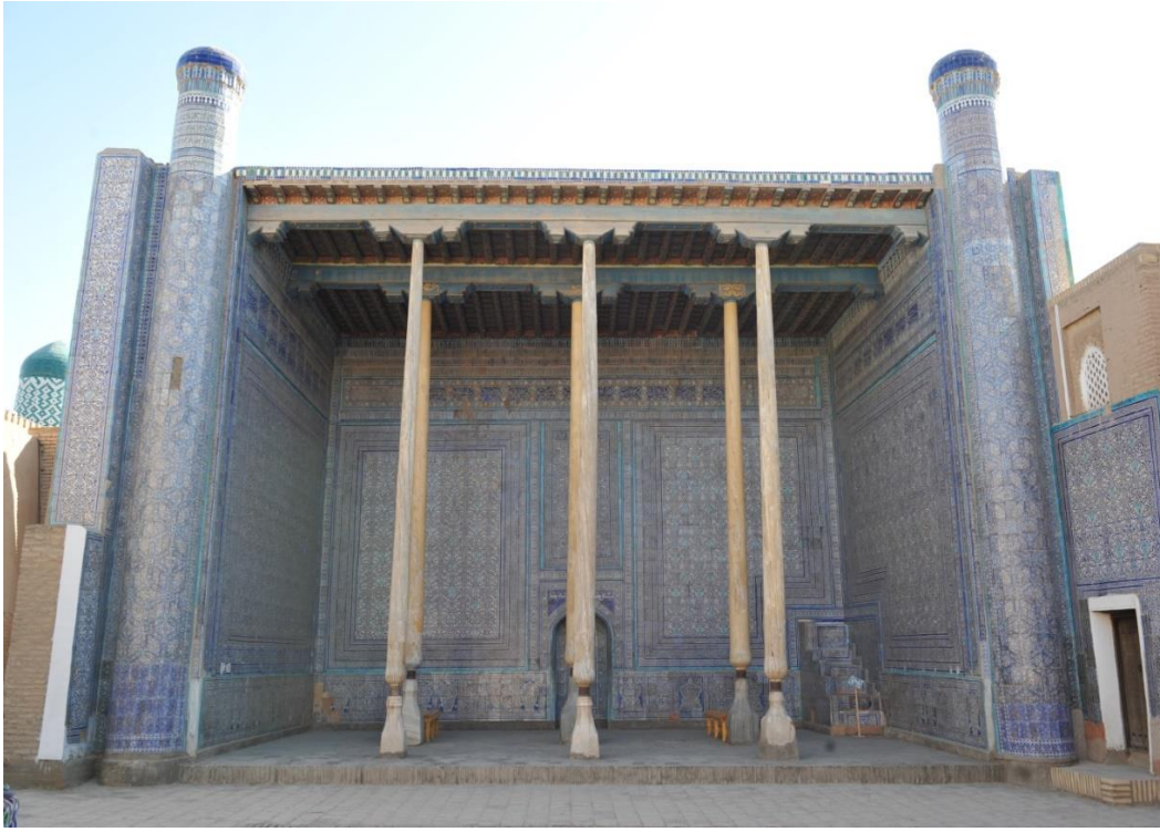
لوحة (٦) المسجد الصيفي بقصر كهنة آراك في خبوة
