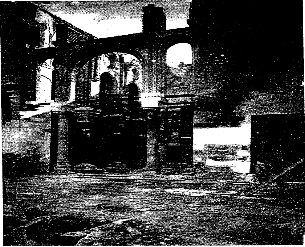
شكل (١٨): صورة فوتوغرافية لحالة إيوان القبلة كما وجدته لجنة حفظ الآثار العربية، بعد إزالة الإضافات المستجدة، والتي تحجب عناصره المميزة.
