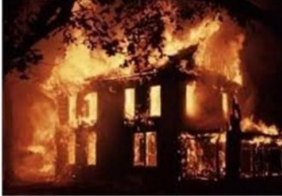
شكل 11 يوضح تأثير الحريق على حوائط المبنى
