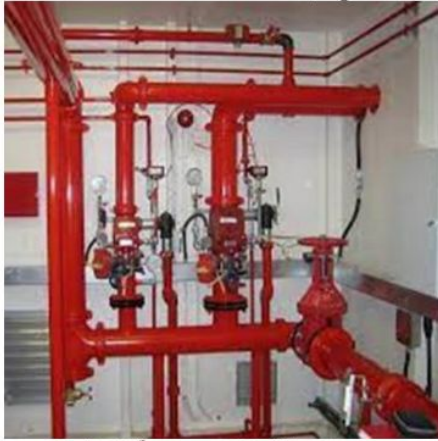
( Risers ) شكل 32 يوضح وقافات المياه
