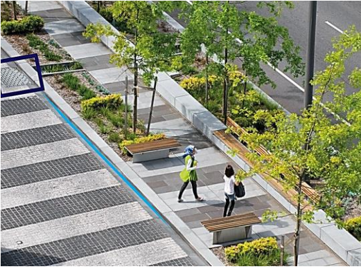
شكل (21) أماكن التقاط مياه الأمطار وتحويلها إلى الخزانات أسفل الطريق لري الحدائق. المصدر: https://tcl.net.au/projects-item/lonsdale-street/
