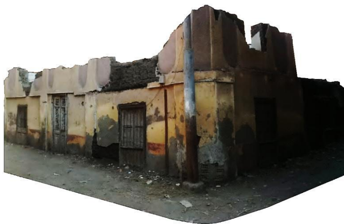
صورة (١) - نماذج من البيوت القديمة في منطقة النواة القديمة بقرية المقاطعة
