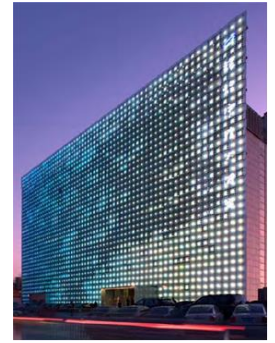
شكل ( ٧٢ ) مشروع جرين بيكس – الصين وفيه استخدام الخلايا الشمسية لتوفير الطاقة وتوفر الكهرباء للوحة اعلانية
