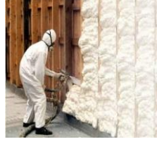
شكل(٥٥) عزل بمادة البوليسترين الرغوي
