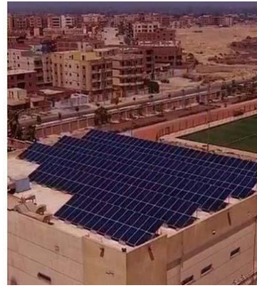
شكل(٩٤) مبني فودافون – بني سويف
