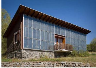
الأشكال (٦٦-٦٧-٦٨) يوضح تأثير استخدام معالجة جدار ترومب في معالجة الفتحات باستخدام اشعة الشمس لتقليل فقد الطاقة
