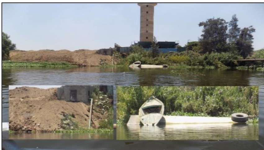
صورة (٤): انهيار سقف مدخل المياه لمحطة التحلية بمنشأة سليمان بمحافظة الغربية، وعمليات ردم للأجزاء المنهارة بجوارها بالجانب الشرقى اتجاه التصوير: ناظرا صوب الشرق تاريخ التصوير: ٢٠١٥/٤/١٣
