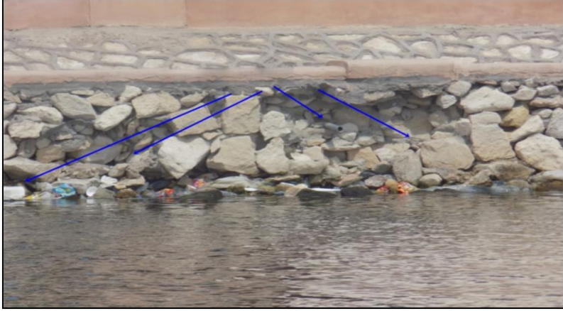
صورة (١٦): آثار عمليات النحت على التغطية الحجرية لرصيف الجانب الغربي لمجرى فرع رشيد بمدينة رشيد بالبحيرة اتجاه التصوير: ناظرا صوب الغرب تاريخ التصوير: ٢٠١٥/٦/١٥
