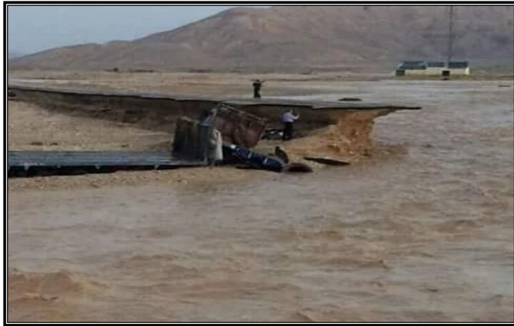
صورة (٢) قطع وإنهيار طريق السويس / الغردقة أمام مخرج وادي أبو حاد قرب رأس غارب
