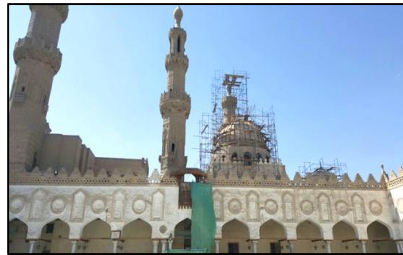
(شكل ١٥): أعمال ترميم القباب والمآذن من خلال مشروع ترميم (الجامع الأزهر) الذي تم تنفيذه عام (٢٠١٨م).
