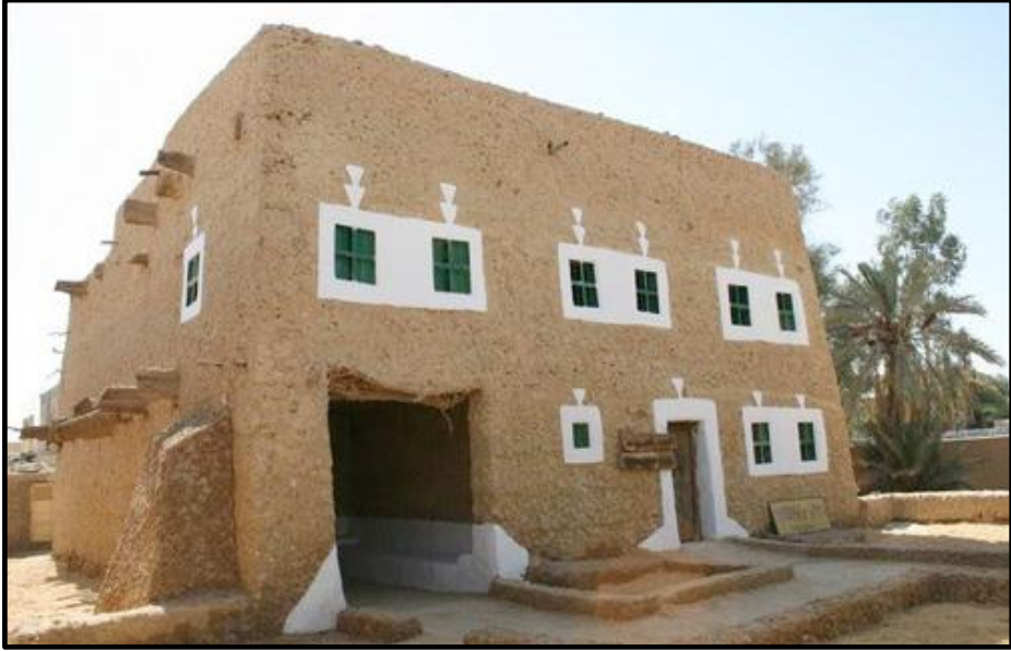
صورة (5) واجهات المباني بمدينة سيوة.
