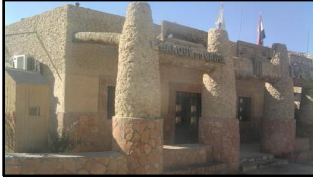
صورة (1) استخدام مادة الكُرشيف في بناء فرع بنك القاهرة بمدينة سيوة.
