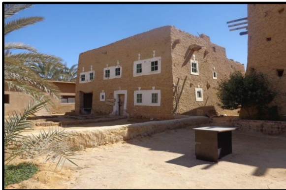
صورة (3) استخدام مادة الكُرشيف في بناء متحف البيت السيوي.
