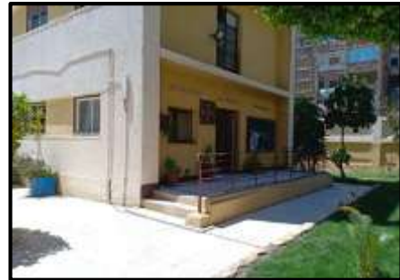
(شكل ٢) مسار الدخول المنكسر بالنسبة للمدخل من البوابة، ويظهر المدخل علي يسار ممر مرتفع بدرجتين بحيث يكون اتجاه الدخول غير مباشر مما يعتبر عيباً في التوجيه. يلاحظ عدم وجود منحدر لذوي الهمم بالرغم من ارتفاع الممر بدرجتين.
