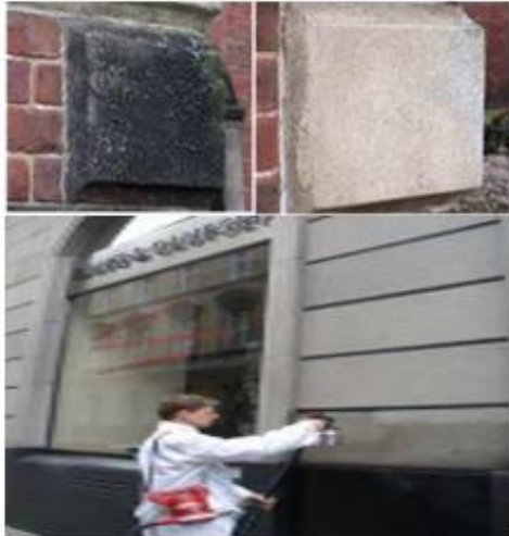
شكل (١٤) الحجر قبل وبعد المعالجة بطلاء النانو
