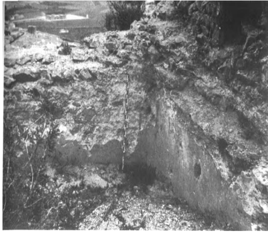
صورة (٣) منظر داخلي لصهريج قلعة قليوثة (٧٩)
