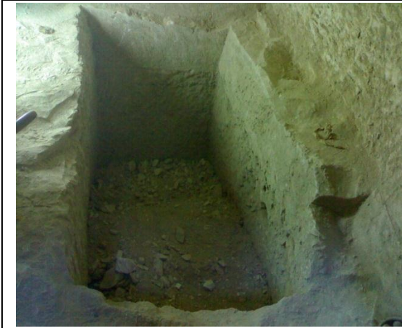
شكل (٩): يوضح البئر بداخل الغرفة الجانبية.
