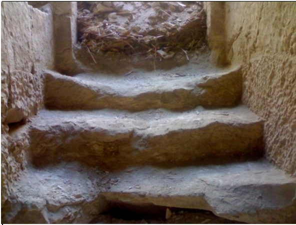
شكل (١١): يوضح الدرجات للمدخل الجانبي الموجود بصالة الأعمدة.
