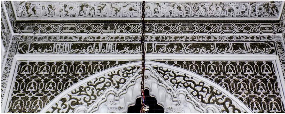
لوحة (٣٧) : الجامع الكبير بتازة : نقوش كتابية بالخطين اللين والكوفي أعلى مربع المحراب .
