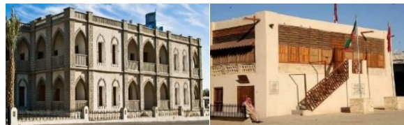
شكل (٢٨) كشك المبارك بعد الترميم (دشتي، ٢٠١٨). شكل (٢٩) المستشفى الأمريكي (NCCAL, ٢٠٢١).
