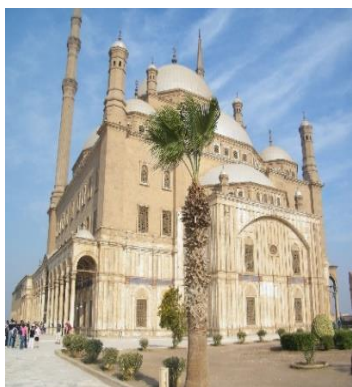
(لوحة ٢٣) جامع محمد علي بالقاهرة وتعامد أربع أنصاف قباب على قبتة المركزية إلى جانب نصف قبة الخامس يعلو حنية محرابه https://i.pinimg.com/originals/33/ed/05/33ed05f7c41fce7cf26f7541e0ef846b.jpg
