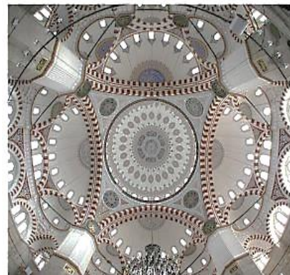
(لوحة ٢٠) قبة جامع شهزاده بإسطنبول وتعامد أربع أنصاف قباب عليها
