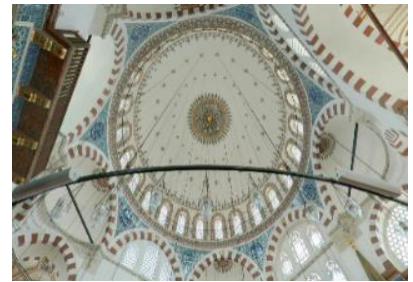
(لوحة ٤) قبة جامع رستم باشا في امينونو بإستانبول على قطاع مئمن وبلاطات جدرانه http://www.3dmekanlar.com/en/3d-turkey.html Accessed at 1/2022
