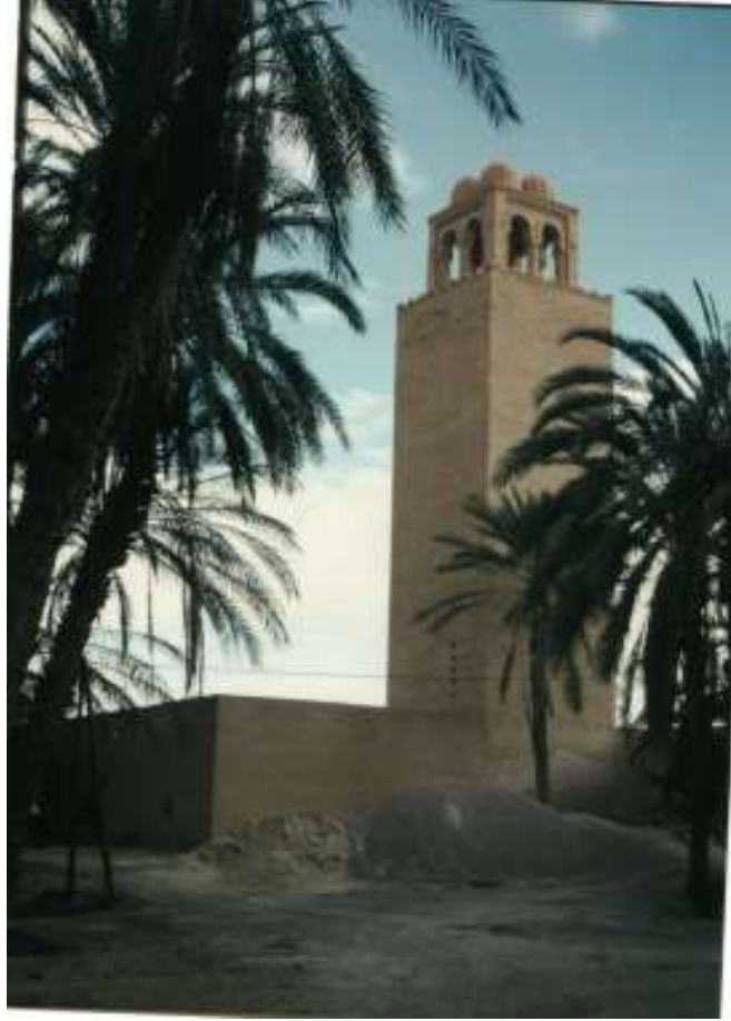
لوحة رقم 20 جامع اولاد ماجد بقريه بدقاش القرن 8هـ/14م وتفاصيل لكتلة الصومعة
