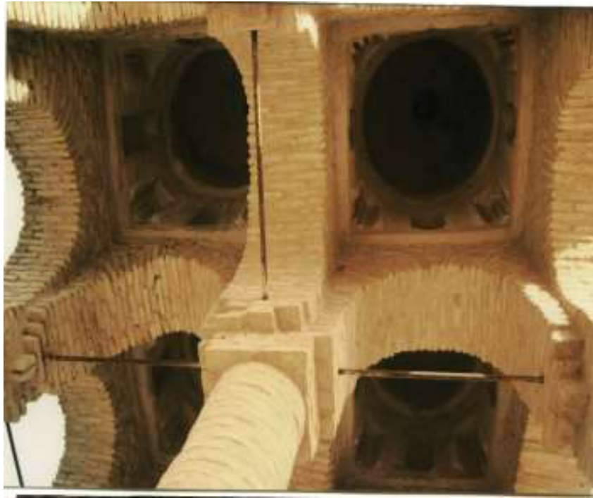
لوحة رقم 25 تفاصيل لمنطقة انتقال القباب الاربعة بصومعة جامع اولاد
