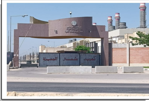
صورة (٢) محطة كهرباء شمال الجيزة (قرية القطا)
