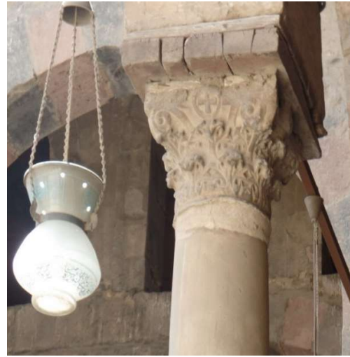
لوحة 5: تاج عمود كورنثي يتوسطه صليب كامل الأضلاع ومحاط بدائرة - الرواق الأيمن لجامع الناصر محمد بن قلاوون - تصوير الباحثة
