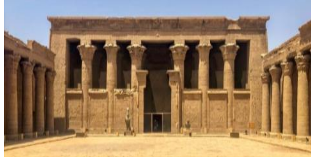
شكل (١٥) حواجز بين الأعمدة لتقليل حدة الإبهار الضوئي ببهو الأعمدة شكل (١٦) فتحات السقف بغرفة المركب المقدس (Pangburn, 2019)
