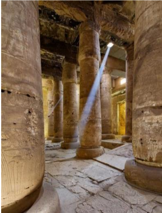
شكل (١٣) الإضاءة العلوية فوق مدخل أحد المحاريب (Smit, 2022) شكل (١٤) الإضاءة من فتحات السقف ببهو الأعمدة (Smit, 2022)
