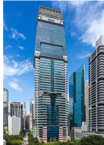
شكل ٨- برج العاصمة في سنغافورة، المصدر (Capital tower، 2021)
