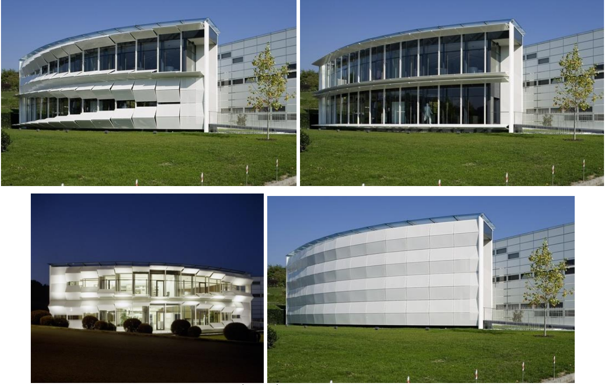
شكل ١٣- الواجهة الخارجية للمبنى عند فتح و اغلاق شرائح الالمنيوم كلياً أو جزئياً، نهاراً و ليلاً، المصدر (Vinnitskaya، 2010)
