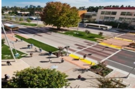
شكل (٤) الطرق والارصفة والمسارات داخل المنطقة الحضرية على مستوى واحد مع اختلاف نوعية الأرضيات لتحقيق سلامة الحركة. المصدر (Landscape Architect., 2008).
