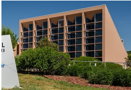
شكل (٢): دمج الخلايا الفوتوفولتية في الواجهة الرأسية المسننة في مبنى المركز التعليمي (NREL) [١٣].
