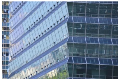
شكل (٤): دمج الخلايا الفوتوفولتية في الحائط المتدرج الخاص بمبنى اتحاد الصناعات الكورية في كوريا الجنوبية [4].
