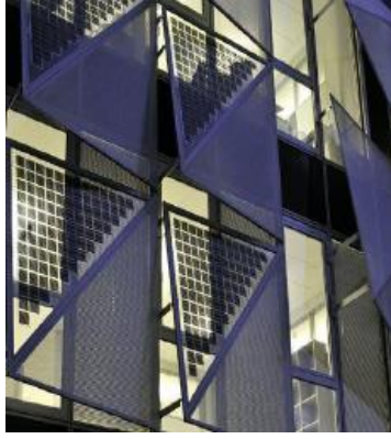
شكل (٦): دمج الخلايا الفوتوفولتية مع الفتحات المعمارية في واجهة مبنى الموسيقى في أستراليا [4].
