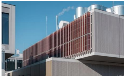
شكل (٨): دمج الخلايا الفوتوفولتية مع كاسرات الشمس الرأسية في مبنى مركز Merck للابتكار في دارمشتات في ألمانيا [16].
