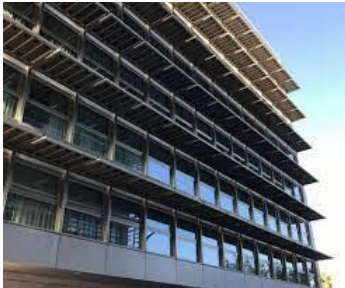
شكل (١٠): دمج الخلايا الفوتوفولتية مع كاسرات الشمس الأفقية في مبنى فندق Monte Malaga في إسبانيا [13].
