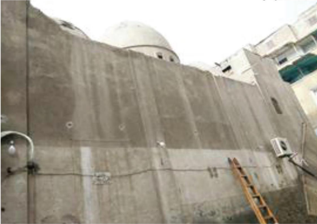
( لوحة ٢ ) الواجهة الجنوبية الشرقية لكنيسة مارجرس بكفر الزيات
