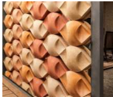
صورة (15) لقطة مقربة لتكسية الواجهة و يتضح double face استخدامها استخدام البلاطات
