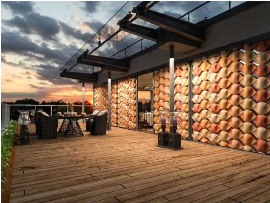
صورة ( 14 ) تكسية حائط مطعم ببلاطات خزفية - يظهر تنوع السطح و الحركة بالاضافة الي العزل الحراري.
