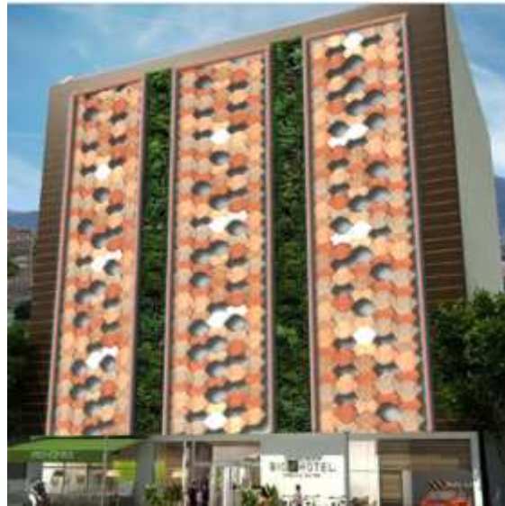
صورة (12) تطبيق تصميم 2 علي واجهة أحد المباني. نلاحظ وجود فراغات في البلاطات لدخول الهواء و الاضاءة، بالإضافة الي تنوع مستويات السطح المستوي لاختلاف السمك، مما يساهم في العزل الحراري و زيادة القيمة التشكيلية للمبني.
