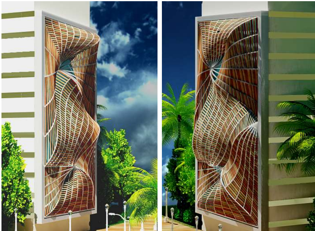
صورة ( 17 أ،ب) تكسية واجهة أحد المباني بوحدات خزفية ( شرائح ) قابلة للتحرك حول محور ليتحول السطح من سطح استاتيكي الى كائناك والتي يمكن التحكم فيها بحساسات للضوء او التحكم اليدوي عن طريق أنظمة التدوير التقليدية .
