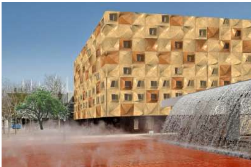
شكل (14) علوي -استخدام البلاطة المفرغة بشكل مزدوج من الناحيتين و تستخدم في الفراغ الداخلي بين الفراغات. سفلي -مرونة تغير شكل البلاطة و اختلاف السطح بتغير زاوية التركيب.
