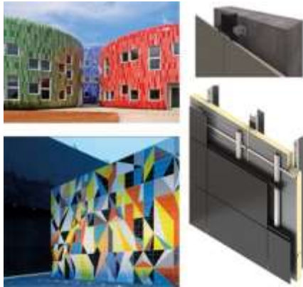
صورة (8) نماذج لواجهات تم استخدام بلاطات منتجة بالكبس الشبه جاف في التغطية المعمارية وطريقة التثبيت الميكانيكي
