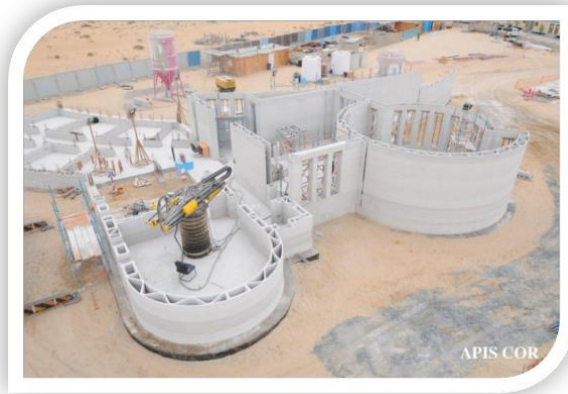
صورة (١٧،١٦) توضح المبنى المكتبي بدبي أثناء طباعته
