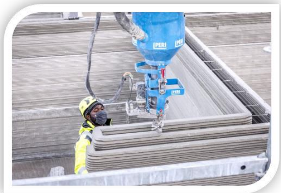
صورة (١٧،١٦) توضح المبنى المكتبي بدبي أثناء طباعته
