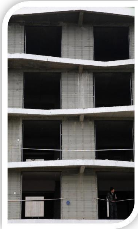
صور ( ٢٦ : ٣٠ ) توضح تفاصيل البناء للفيللا والمبنى المتعدد الطوابق قبل التشطيب النهائى
