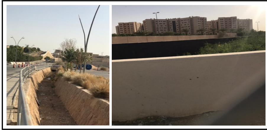
لوحة (٤) : تبرز صورة لصناديق تجميع وقنوات تصريف الأمطار السطحية بحي جامعة الملك سعود.
