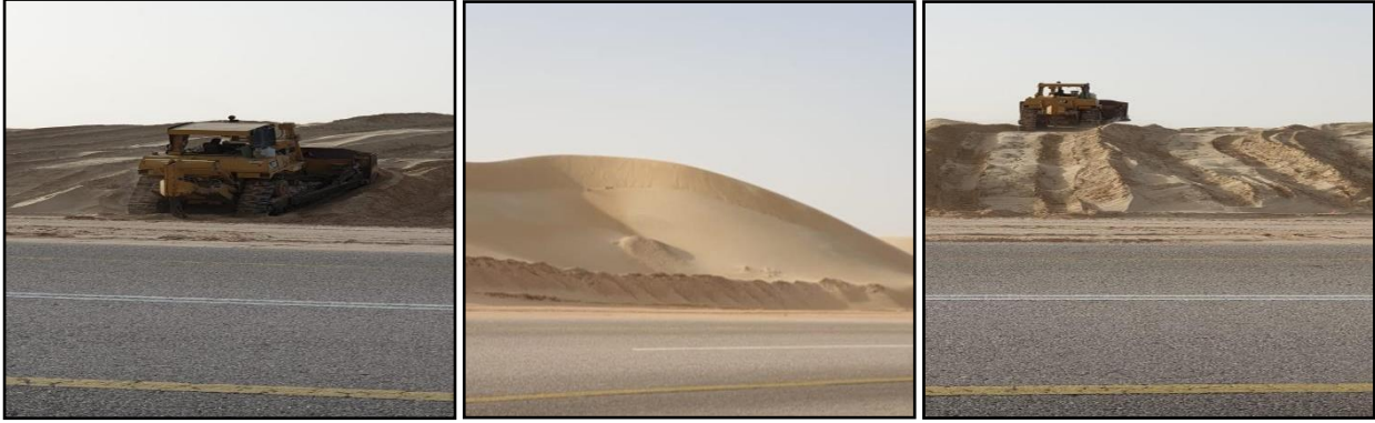
شكل 15: استخدام الجرافات في إزالة زحف الكثبان على طريق العقير – الهفوف (المصدر: الدراسة الميدانية)
