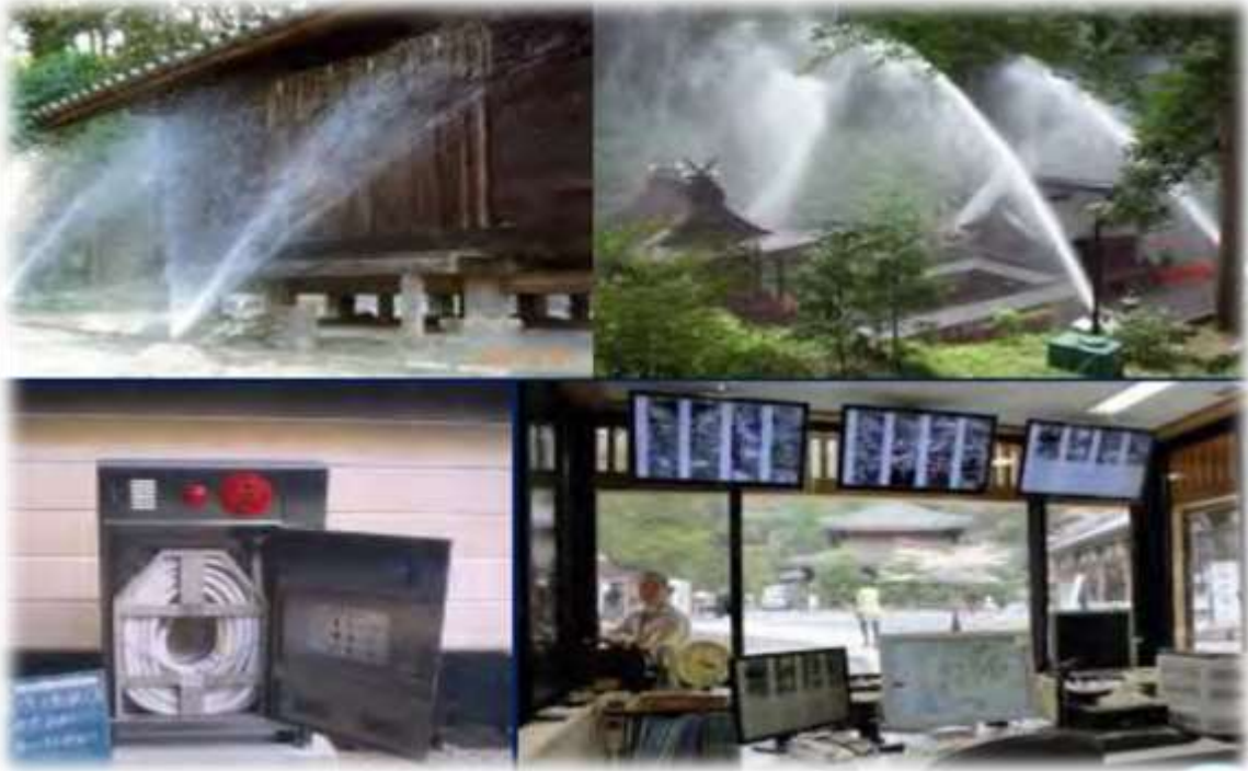
( شكل رقم 6 ) أنظمة متقدمة لإطفاء الحرائق التي تهدد المباني التراثية يتم التحكم بها من خلال غرفة تحكم إلكترونية خارج الموقع – اليابان
