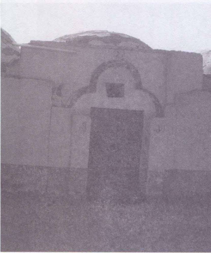
(لوحة ٥) المسجد ، واجهة المدخل.
