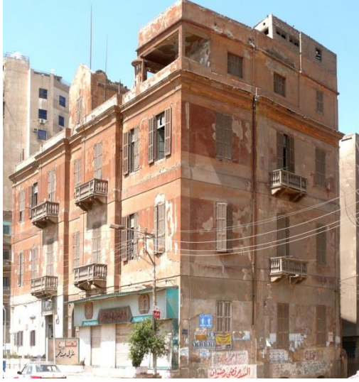
لوحة (٢) الواجهتان الجنوبية والغربية والجنوبية الشرقية بمنزل الخواجة يني بابان (تصوير الباحثان)
