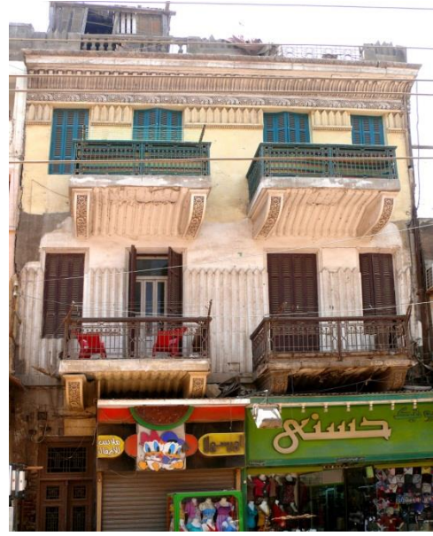
لوحة (١٣) الواجهة الشمالية الشرقية بمنزل الخواجة مرزوق أفندي (تصوير الباحثان)
