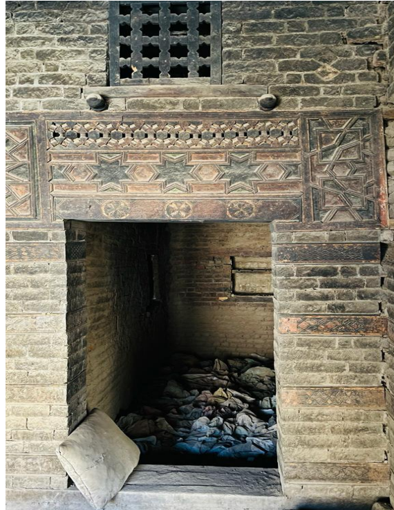
لوحة (٤٠) منظر عام للعتب السابع والذي يعلو مدخل غرفة بالطابق الثاني (تنشر لأول مرة).
