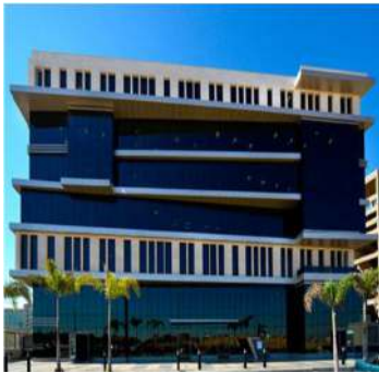
صورة 1 الواجهة الرئيسية لمبنى رابية
