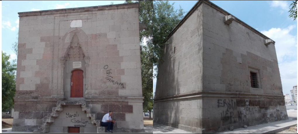
لوحة (٢٦): الواجهة الشمالية ومدخل ضريح علي بشرو، تصوير الباحثة
