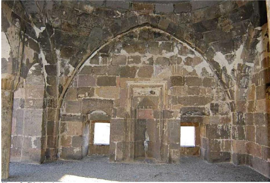
Süleyman Bey Türbesi, iç mekan.
