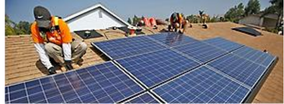
شكل (9) تركيب الخلايا الشمسية بأسطح المباني، المرجع https://www.nok6a.net
