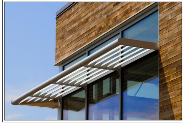
شكل ١٥، توضح رفوف خارجية لمنع اختراق أشعة الشمس المباشرة (٢٠١٦ / Denmarsh Photography, Inc)
