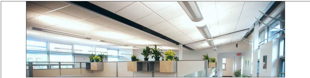
شكل ١٤، استخدام إضاءة فلورية (T-5) في مساحات العمل (Lenny Antonelli / ٢٠١٦)
