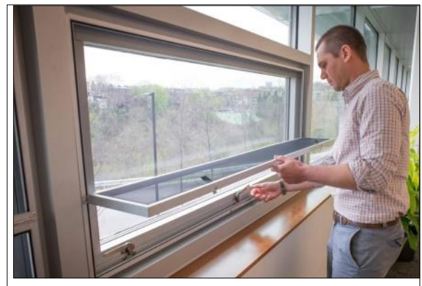
شكل ٧، يتضمن مبنى "فيس" نوافذ قابلة للتشغيل من قِبَل المستخدم (Phipps / ٢٠١٤)
