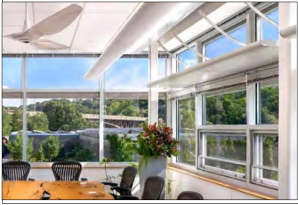
شكل ١٦، توضح رفوف شمسية داخلية توجه أشعة الشمس المباشرة (٢٠١٤ / Phipps)
