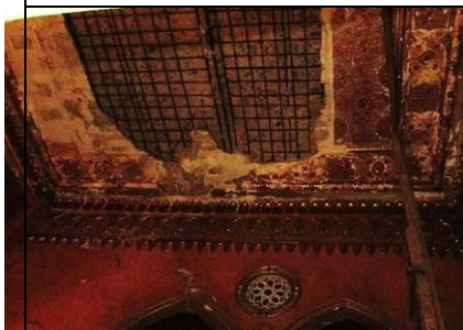
(لوحة ١٢) الحديد والخرسانة المسلحة بالسقف
