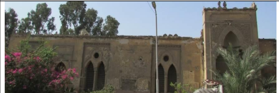
(لوحة ٣) كتلة المدخل البارزة والواجهة الشمالية الشرقية للمبنى العمودى على المدفن
