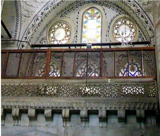
لوحة (٢٦) الكوابيل الحاملة لبروز الرواق العلوي بجامع حكيم أوغلو - نقلاً عن:
