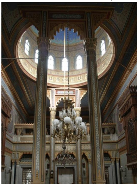
لوحة (٣٥-أب) الكواويل التي ترتكز عليها قبة جامع الحميدية ببلدز - نقلاً عن :
