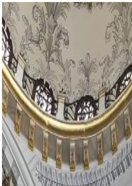
لوحة (٥٢ب) الكواويل التي يرتكز عليها الممر المحيط بباطن قبة جامع نصرتيه.
