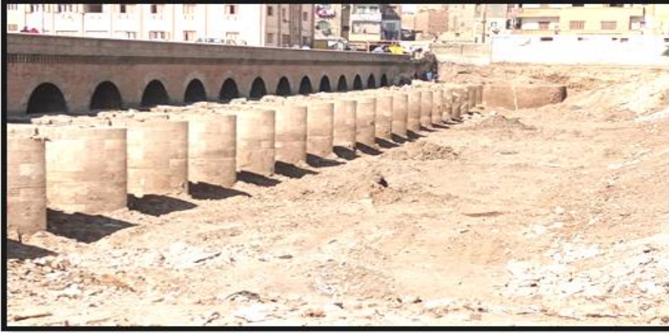
لوحة ( 7 ) حرم القناطر من الجهة الشرقية بعد رفع المرديم
