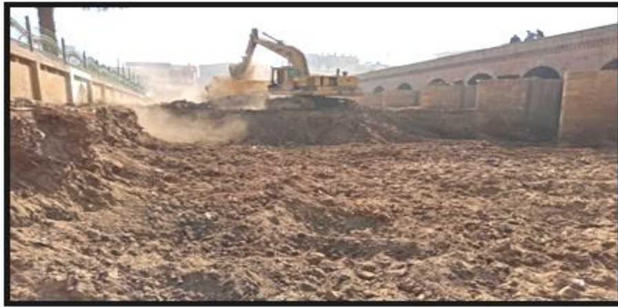
لوحة (17) حرم القناطر من الجهة الشرقية أثناء رفع الرديم
