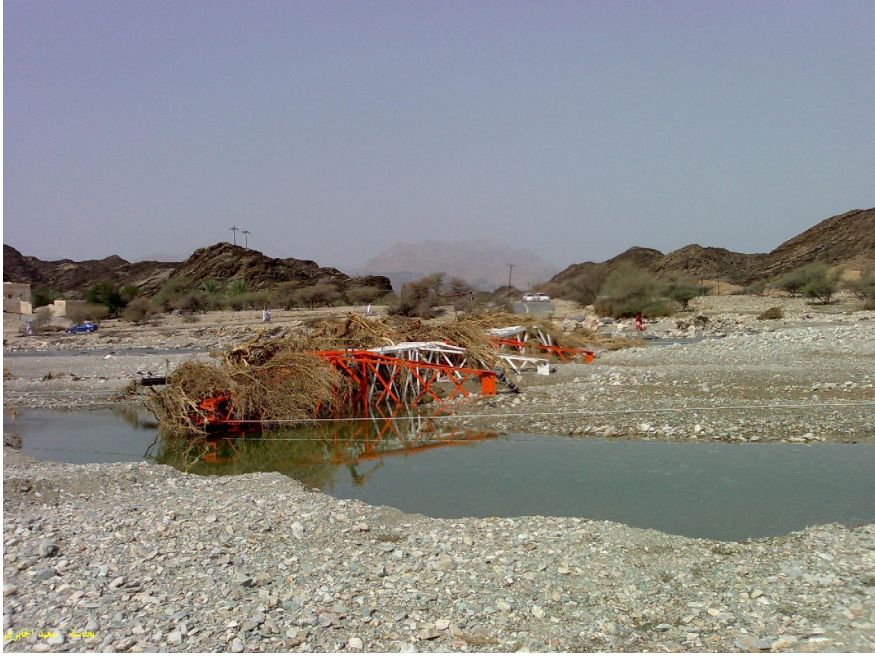
شكل رقم ٣ - أحد الأبراج المنهارة بسبب إعصار جونو بسلطنة عمان [٤]
