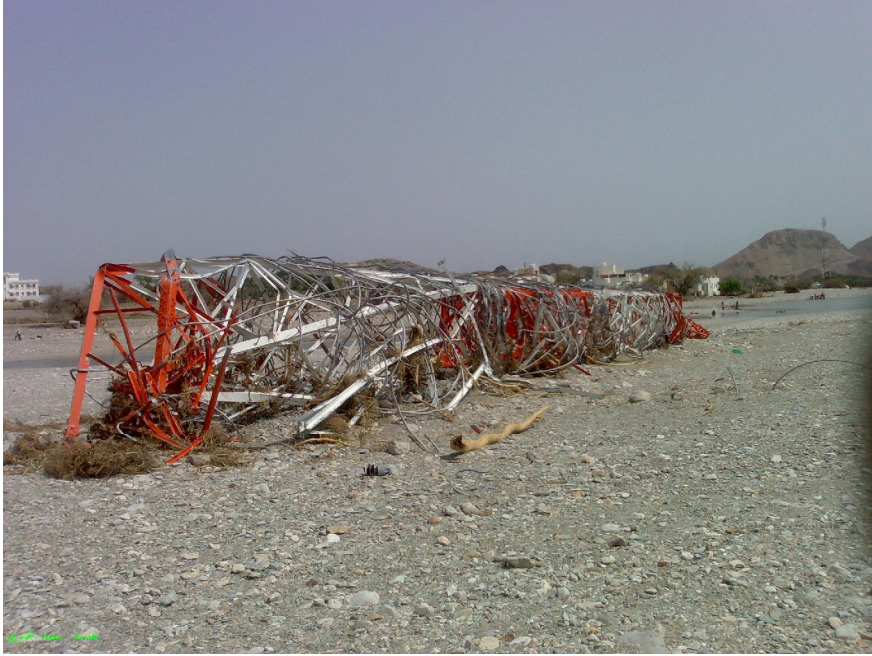
شكل رقم ٥ - التفاف موصلات الألومنيوم حول برج جرفته مياه الوادي والرياح العاتية بسبب إعصار جونو بسلطنة عمان [٢٧]
