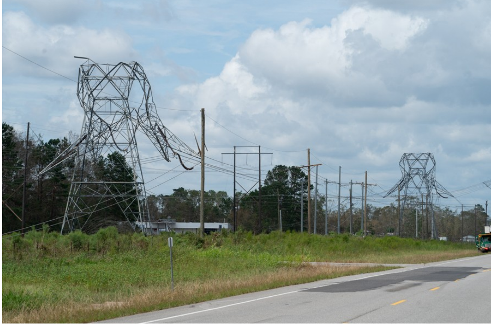
شكل رقم ٢ - أبراج مدمرة بسبب إعصار لورا بولاية لويزيانا [٢٧]
