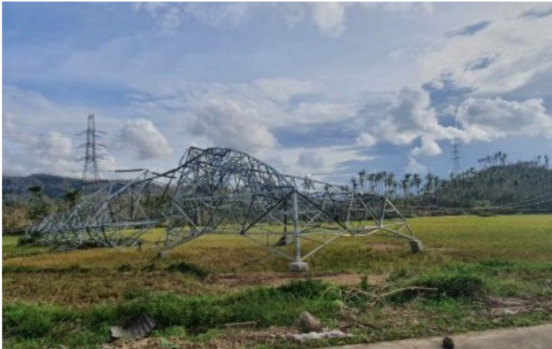
شكل رقم ١ - برج مدمر بسبب إعصار رولي في الفلبين [٢٦]
