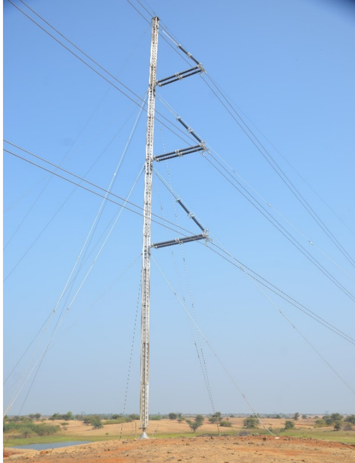
شكل رقم ٦ - برج طوارئ مؤقت يحمل دائرة مفردة ذات ثلاثة أطوار [٣٠]
