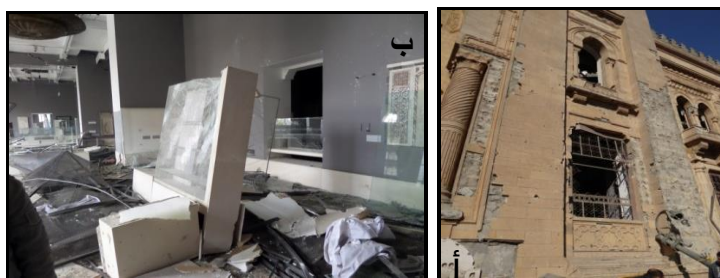
لوحة (1) توضح الصورة (أ) تطاير نوافذ المتحف، وتوضح الصورة (ب) ميل فاترينة عرض بشكل كلى وكل ذلك نتيجة لقوة الإنفجار
