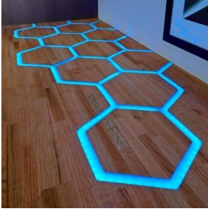
صورة ٢٠: نموذج لحفر الراوتر بالأشكال الهندسية وملؤها بالإيبوكسي
