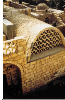
صورة ( ١٠ ) الفتحات المثلثة لمرور هواء البحر البارد داخل المنزل
