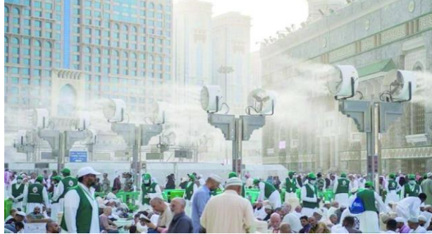
صورة رقم (٢) نموذج لنشر مراوح الرذاذ المائي في ساحات المسجد الحرام لتبريد الجو
