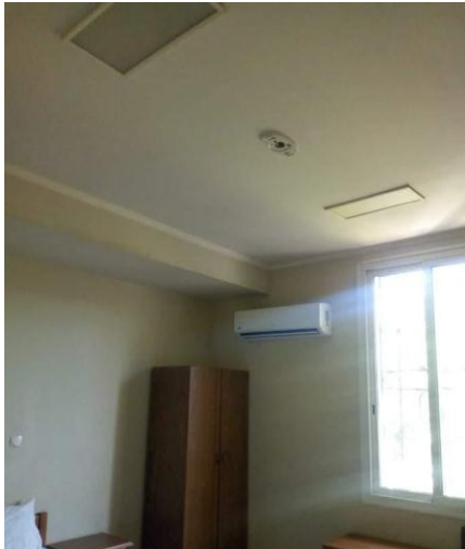
شكل (٦) يوضح عناصر الإضاءة المعلقة بالأسقف والحواجز المعدنية علي النوافذ و أركان الفرش الغير منحنية بغرف العزل
