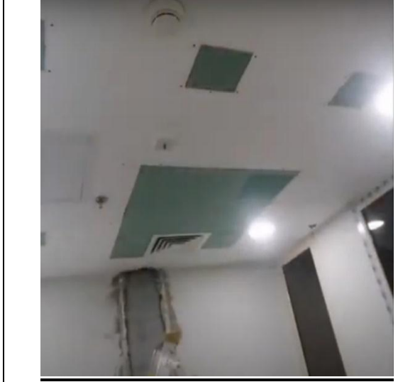
الشكل (٢٠-٢): تركيب الأسقف المعلقة داخل الغرفة
