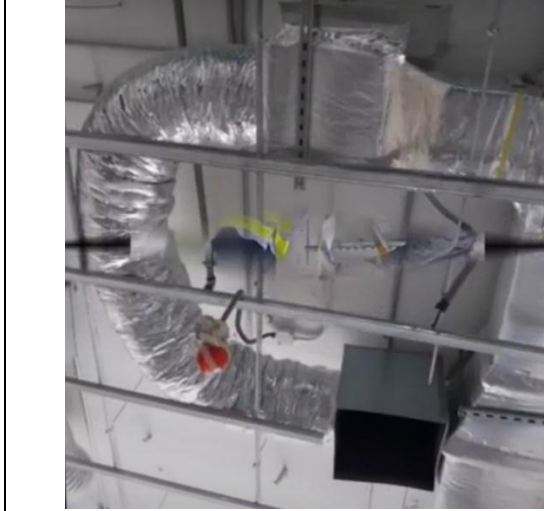
الشكل (١٧-٢): أعمال تجهيز الحوائط الداخلية والخارجية والأسقف وتركيب مسارات التكييف
