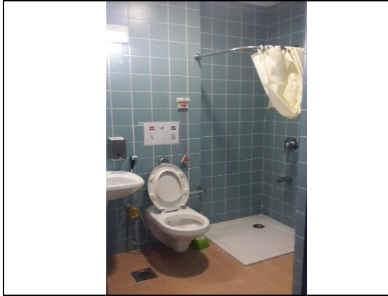
الشكل (١٠-٢): حمام المريض بغرفة العزل بعد تركيب وسائد المساعدة وانظمة استدعاء الطوارئ
