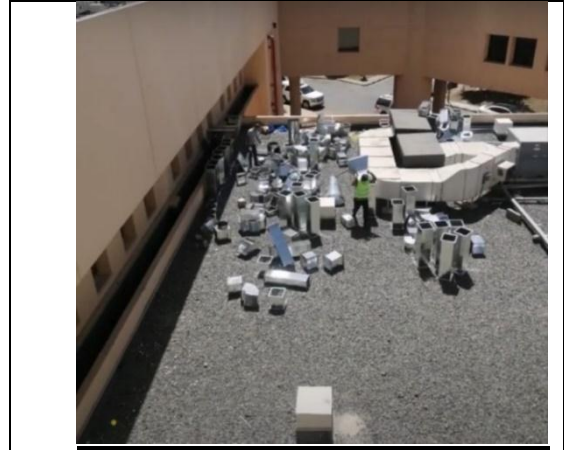
الشكل (١٨-٢): الأعمال المدنية والميكانيكية لأجهزة التكييف على السطح المقابل للغرف
