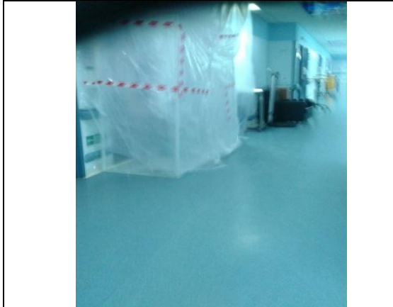
شكل (٢-٦): تأمين منطقة العمل لحماية باقي أجزاء المستشفى في المباني القائمة لنموذج الدراسة.
