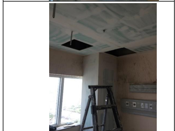
الشكل (٨-٢): تنفيذ السقف المعلق المصمت للغرفة من ألواح الجبسون بورد مع توفير فتحة صيانة.
