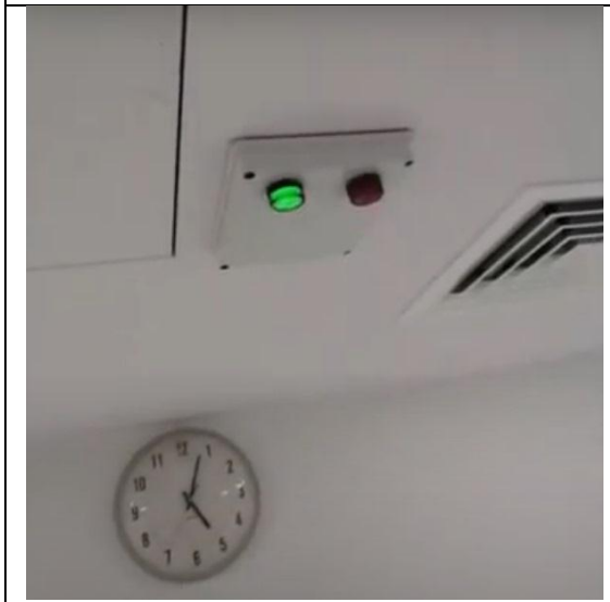
الشكل (٢١-٢): تركيب وحدات المراقبة داخل الغرفة
