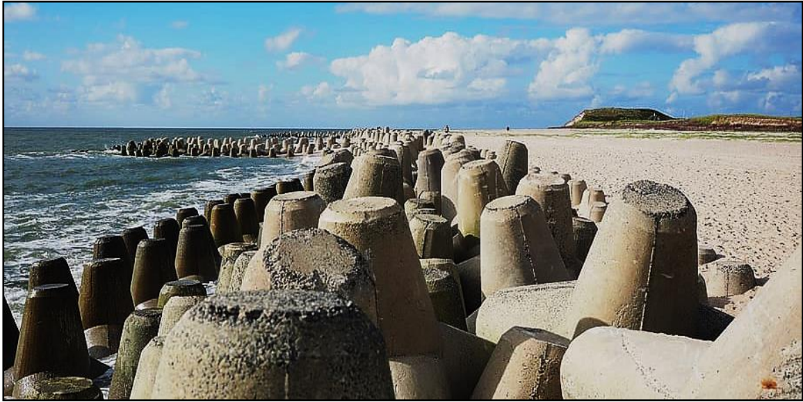
شكل (٤) حواجز الأمواج في شرقي مدينة رأس البر غرب مصب دمياط.
